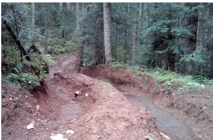
Оштећење на шумским путевима примјеном форвардера у ШПП Ханпјесачко
