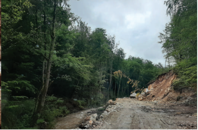
Земљани радови на изградњи МХЕ
