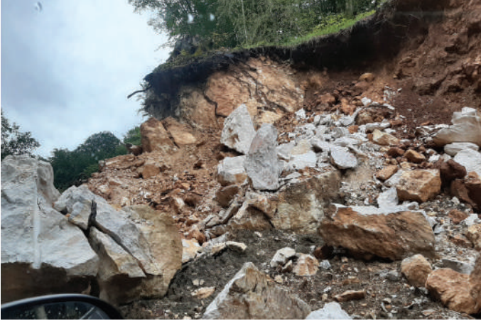
Урушавање обале приликом земљаних радова на изградњи МХЕ
